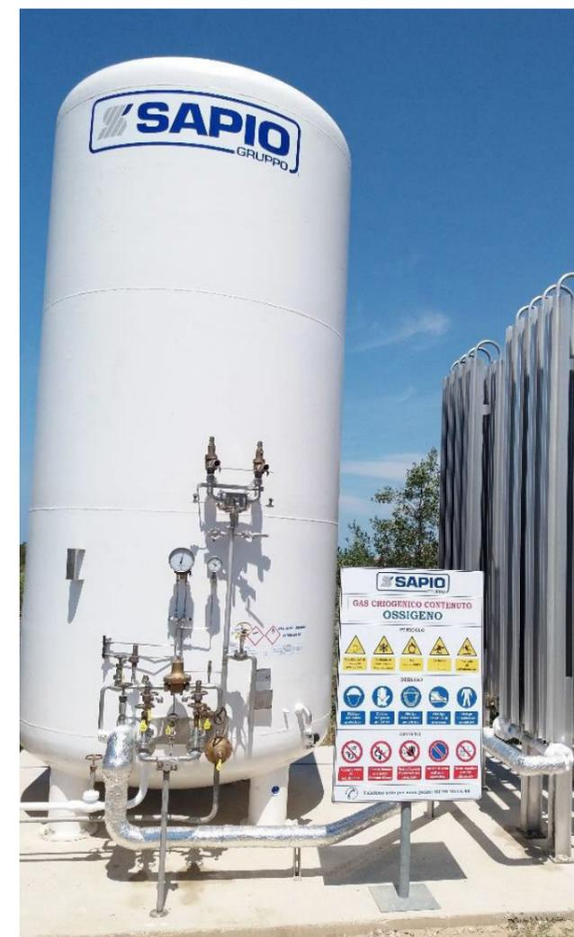
Serbatoio e vaporizzatore
